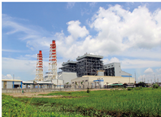
菲律宾普丁巴图 135MW 燃煤电站一期二期项目
