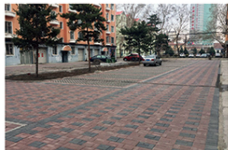
铺设好透水砖的海绵城市小区路面
