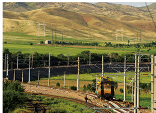
乌兹别克斯坦马拉康德——卡尔西铁路电气化改造项目
